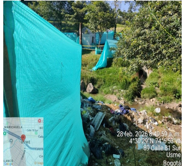
Fotografía No. 8. Ronda hídrica y cauce con presencia de residuos ordinarios.
