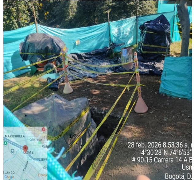
Fotografía No. 6. Área de micropilotaje cubierta.
