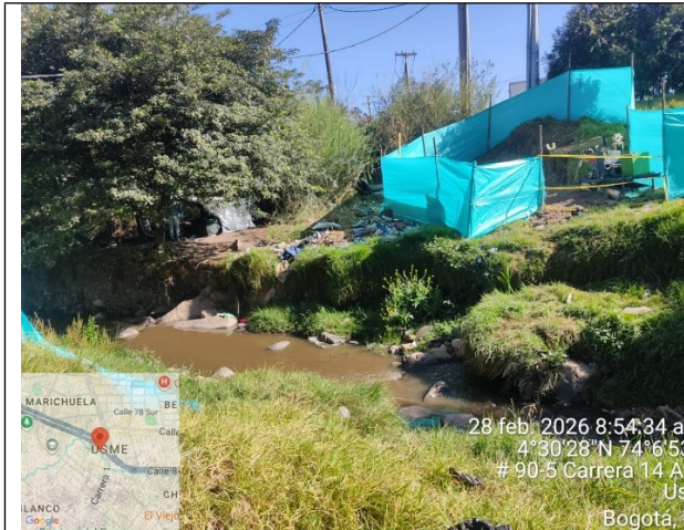
Fotografía No. 1. Cauce Quebrada Yomasa, zona delimitada con polisombra.
