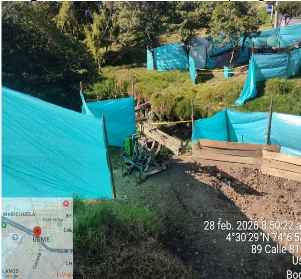
Fotografía No. 7. Zona de trabajo delimitada con polisombra y maquinaria.
