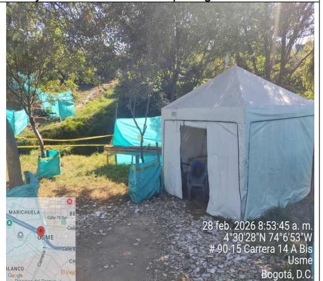
Fotografía No. 4. Campamento de materiales y herramientas, con arbolado protegido.
