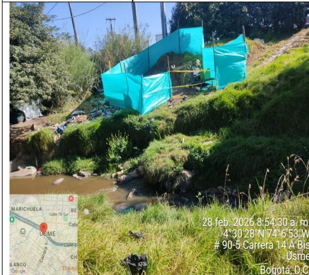
Fotografía No. 3. Zona de trabajo delimitada con polisombra, cambuche con presencia de personas en condición de habitabilidad de calle.
